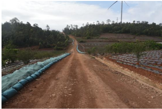
道路外侧覆土、表土挡护、撒播草籽、密目网遮盖、排水沟
