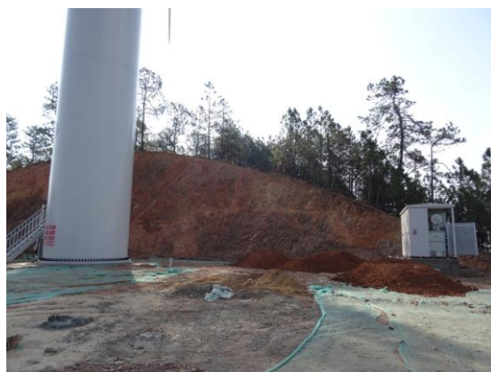
风电机组场地密目网临时遮盖、表土回铺
