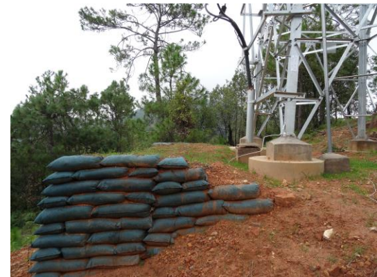
集电线路工程临时挡护及绿化
