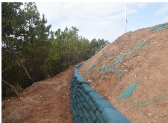
风电机组场地坡脚挡护
