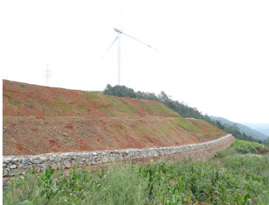
2#渣场坡脚挡护、排水、边坡绿化（2020.09.05）
