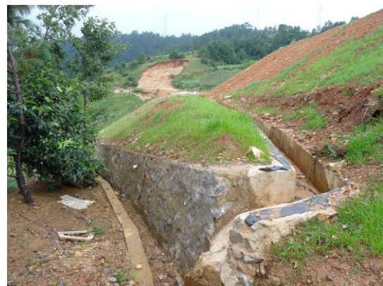
2#渣场坡脚挡护、排水、边坡绿化（2020.09.05）
