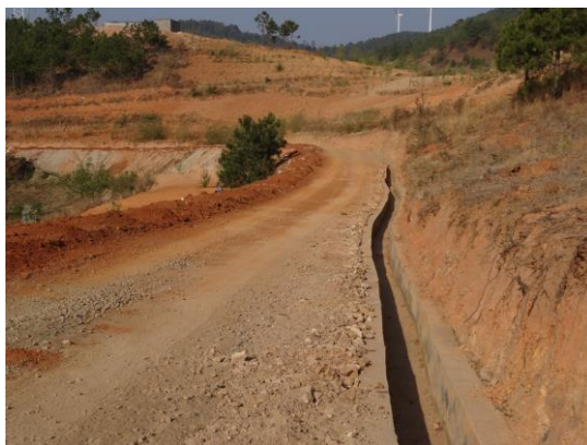
道路外侧覆土、排水沟(2020.3.28)
