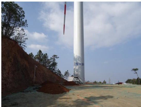
风电机组场地密目网临时遮盖、表土回铺
