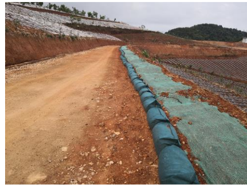
道路外侧覆土、表土挡护、撒播草籽、密目网遮盖、排水沟
