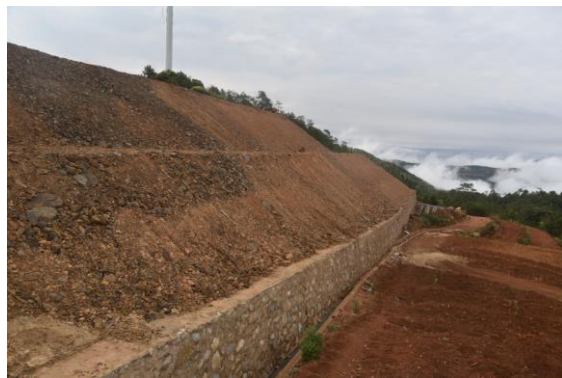
2#渣场挡墙、边坡削坡及排水沟
