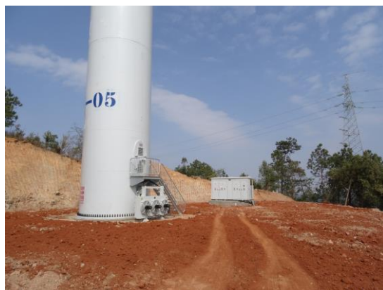
风电机组场地表土回铺
